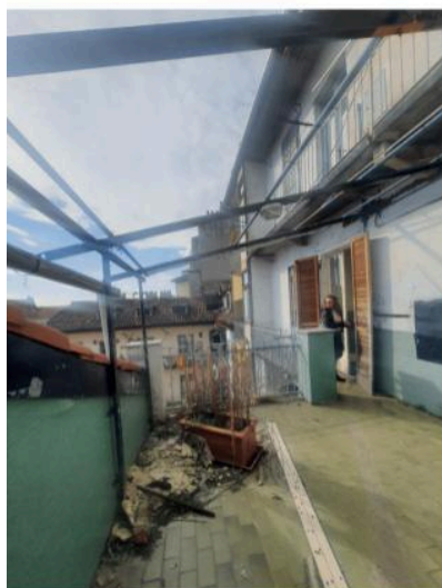
terrazzo piano quarto
